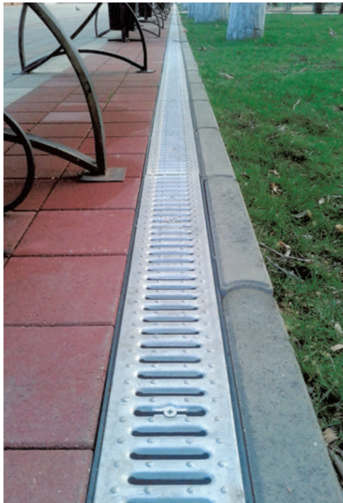
Городской парк, водоотводные лотки Gidrolica® Standart с оцинкованными решетками
