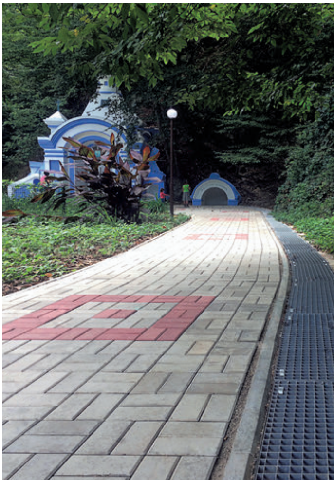
Краснодарский край, Горячий Ключ, водоотводные лотки Hidrolica® Light
