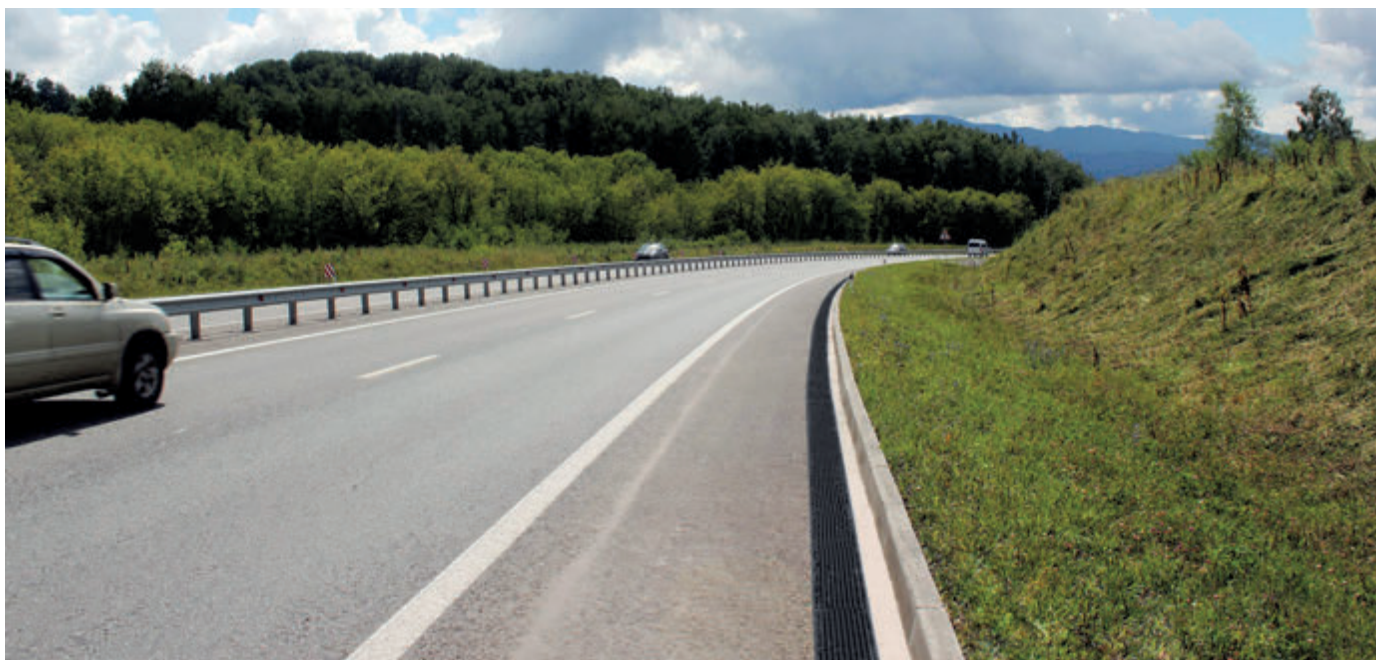
г. Новосибирск, съезд с трассы, водоотводные лотки BGZ-S с чугунными решетками
