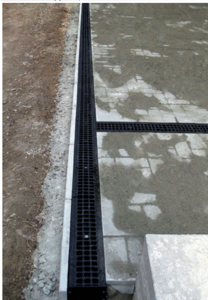
г. Новосибирск, частный дом, водоотводные лотки Hidrolica® Standart с пластиковыми решетками
