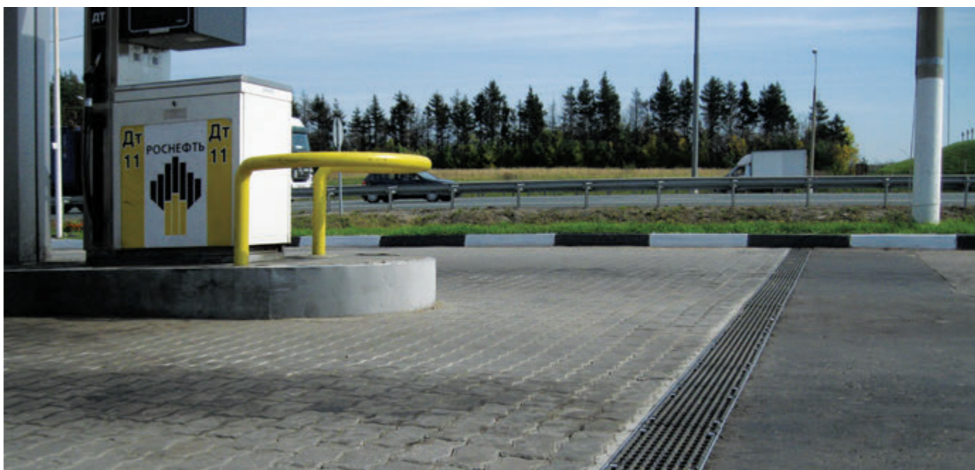
Роснефть, сеть АЗС, водоотводные лотки BGU-Z с чугунными решетками
