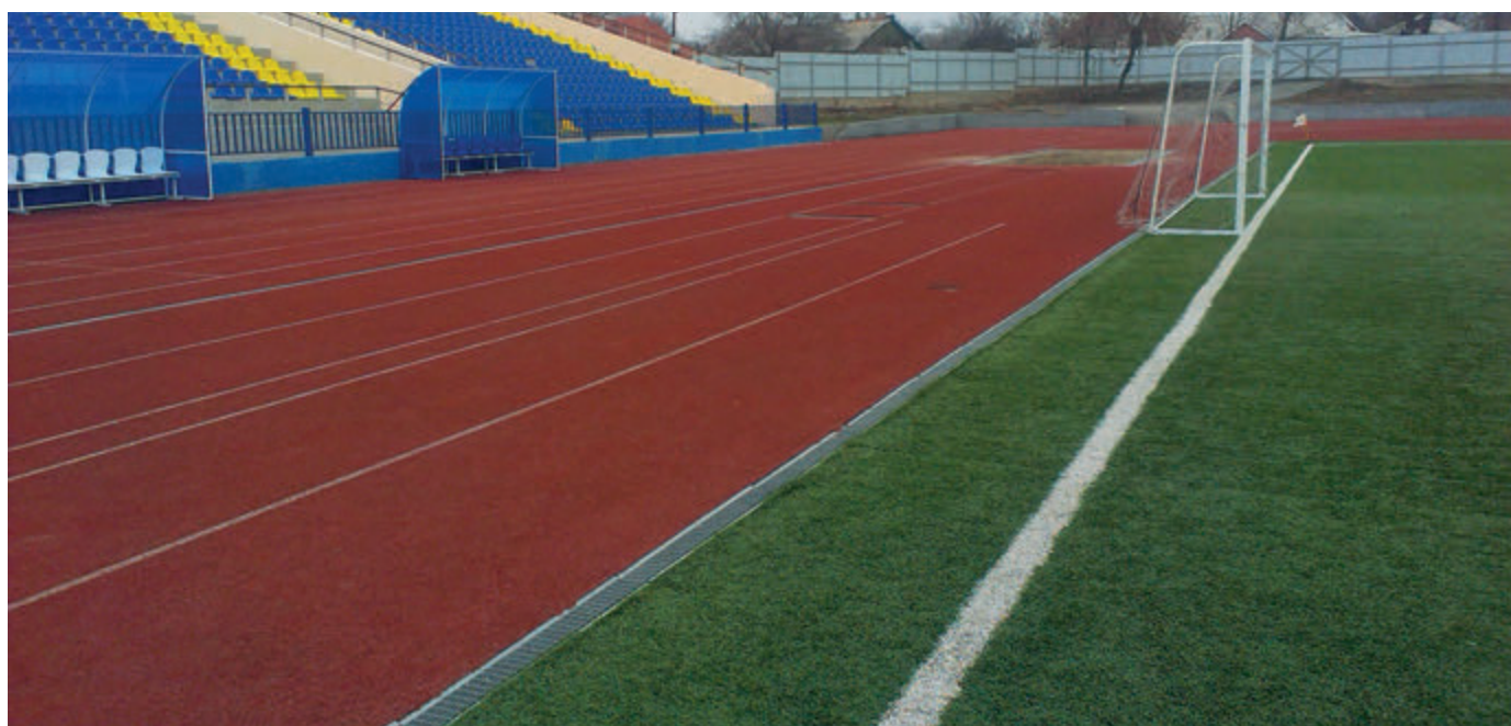
Стадион г. Новошахтинск, водоотводные лотки Gidrolica® Standart Plus со стальными оцинкованными решетками
