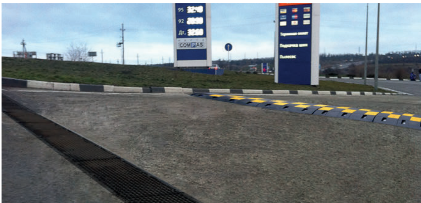
Заправка Мегapolis, Ростовская область, водоотводные лотки BGZ-S с чугунными решетками
